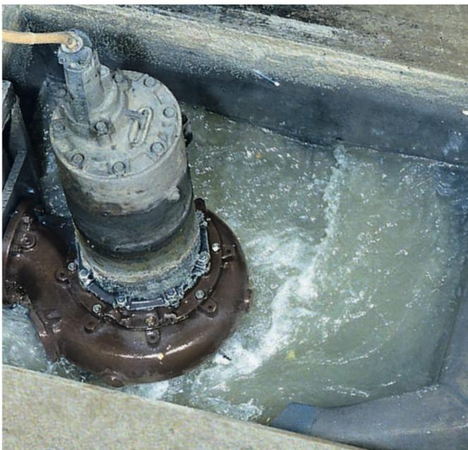
Schmutzwasserpumpe mit eigengekühltem Motor im Pumpensumpf
