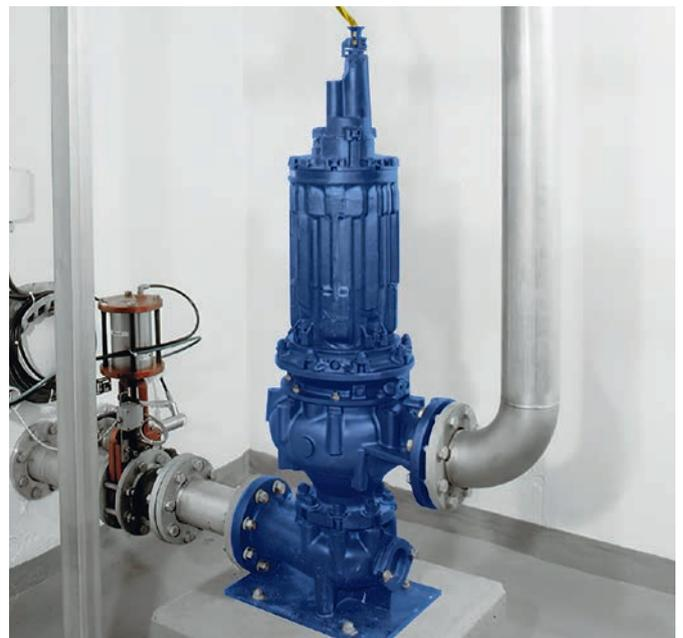
Trocken aufgestellte Abwasserpumpe, Motor mit Konvektionskühlung
